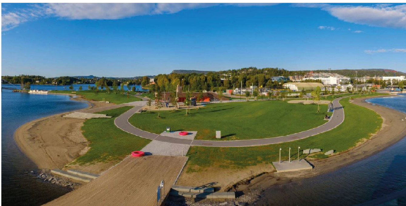
Massehåndtering; her Kadettangen i Sandvika. Området er en utfylling som hovedsakelig består av overskuddsmasser fra den tidligere E16-traseen., Bærum kommune
