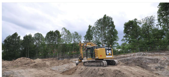
Avtjerna skal brukes til mellomlagring, gjenvinning og varig deponi av stein i Ringeriksbane-/ E16- utbyggingen. Bilde: www.baerum.kommune.no
